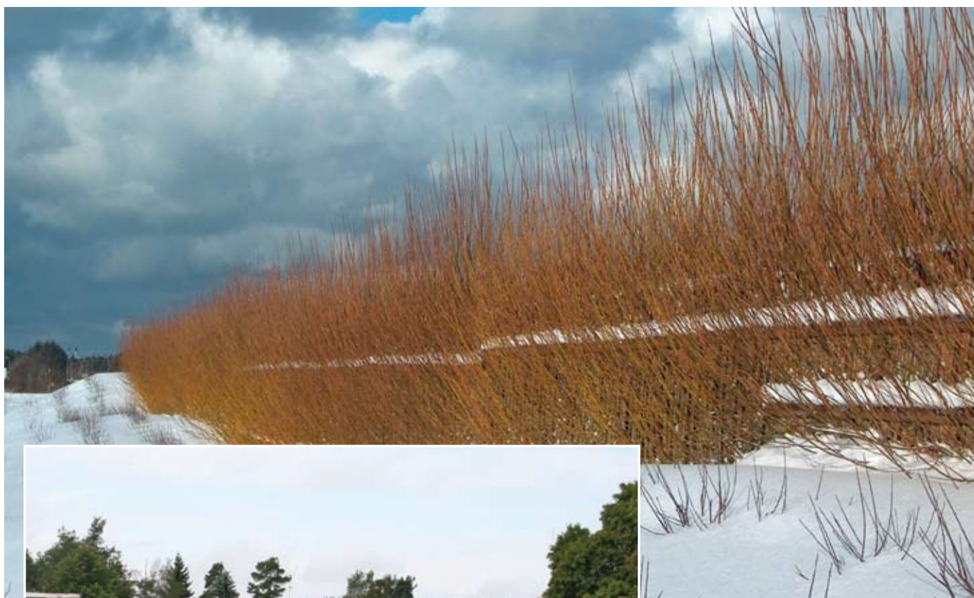
Figur 2. Rettesnor eller begrænsning? PileBygs præmierede støjskærm i levende pil (vinterfoto). Den lader sig ikke umiddelbart CE-mærke, fordi de levende piletræer indgår som en del af den bærende konstruktion.
