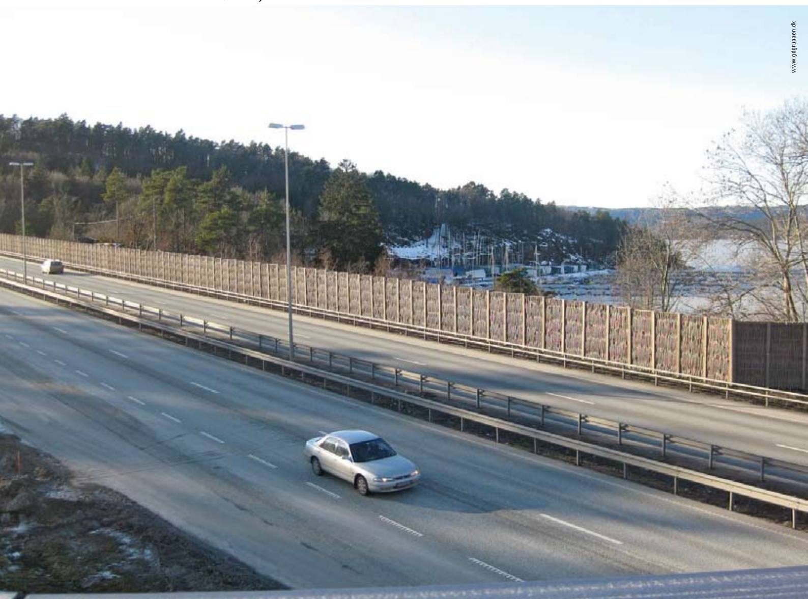
Figur 4. PileBygs støjskærm i tørret pil ved ny E18 i Norge. PileByg a/s blev kun kvalificeret som leverandør til udbygningen af E18 Grimstad-Kristianssand forudsat, at støjskærmene var CE-mærket.
