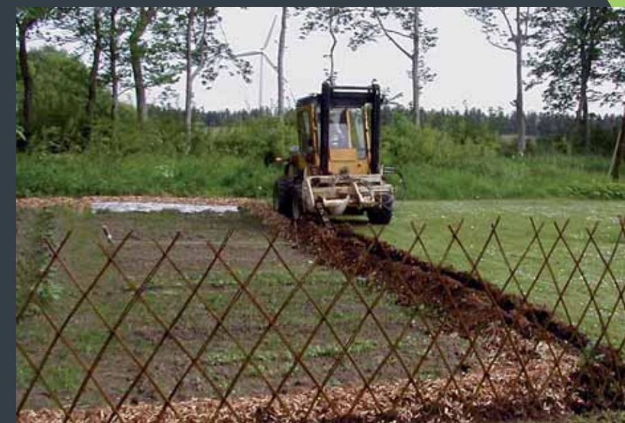
Med en kædegraver kan professionelle anlægsfolk etablere hegnet til en meget konkurrencedygtig pris.
