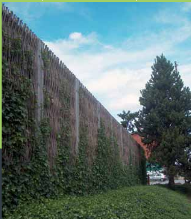
Støjskærm, DET GRØNNE ELEMENT® i tørret pil, for Københavns Amt.
