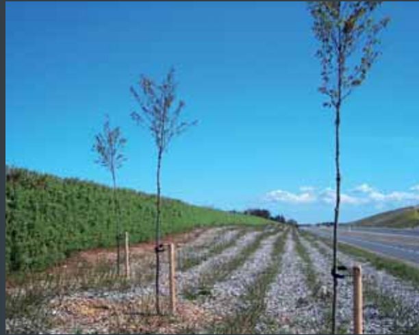
Støjskærm, DET GRØNNE ELEMENT® i levende pil, for Vejdirektoratet.
