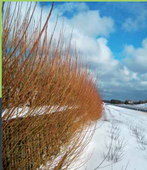
Støjskærm, DET GRØNNE ELEMENT® i levende pil, for Vejdirektoratet.
