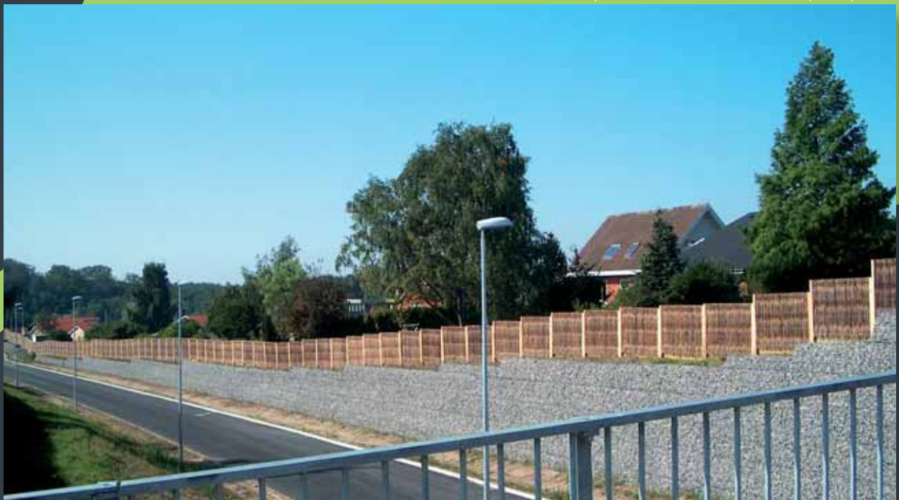
Støjskærm, DET GRØNNE ELEMENT® i tørret pil, for Fyns Amt.
